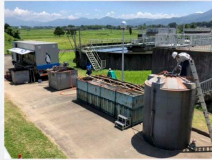
汚水から汚泥を取り除いた処理水と汚泥とに分類してしている。
